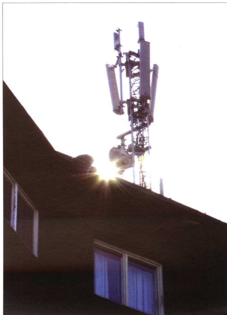
瑞典通信基础设施先进， 这是架设在屋顶上的3G天线
