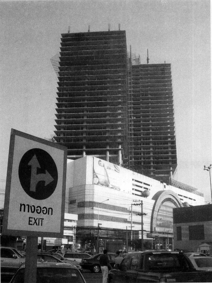
1998年的金融危机使泰国经济受到重创，图为泰国因金融危机造成的烂尾楼正在等待经济复苏。
