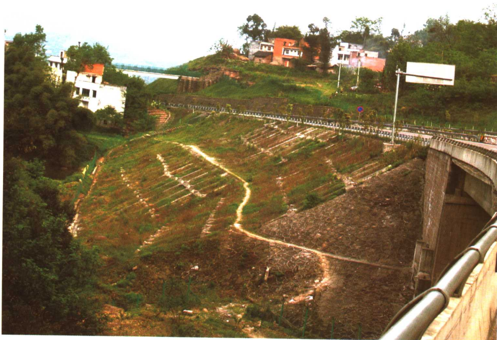
↑ 锚索框架加固菜梯子大桥万州端软基高路堤 ↓ 注浆和锚索框架结合治理分水中学路堤滑坡
