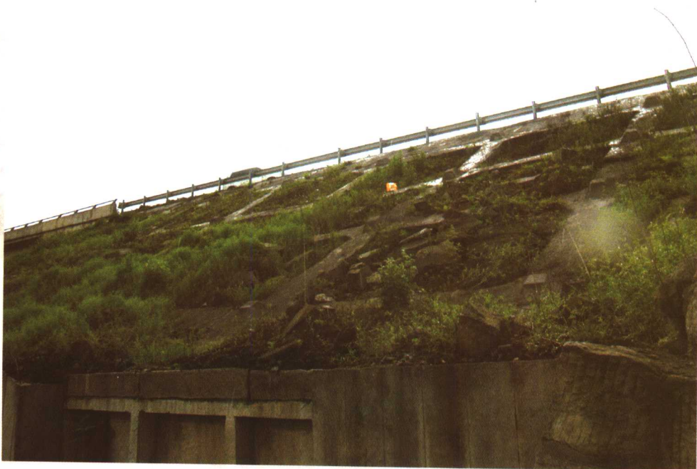
↑ 锚索框架加固菜梯子大桥万州端软基高路堤 ↓ 注浆和锚索框架结合治理分水中学路堤滑坡
