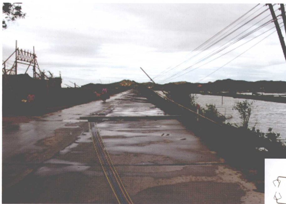
饶平公路旁边电杆被大风吹倒。
