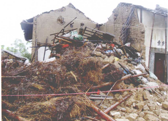
五华县部分民房倒塌。
