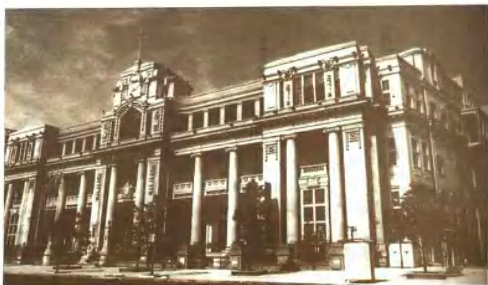
沈祝三“汉协盛”建造的武汉汇丰大楼
