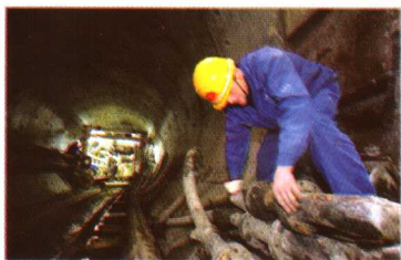
↑ 地铁施工过程
