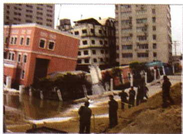
↑ 因地下水超采造成楼体塌方
