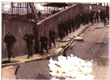
↑ 因地下水超采造成道路塌方
