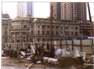
↑ 地铁施工降水排放过程
