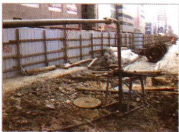
↑ 地铁施工降水井
