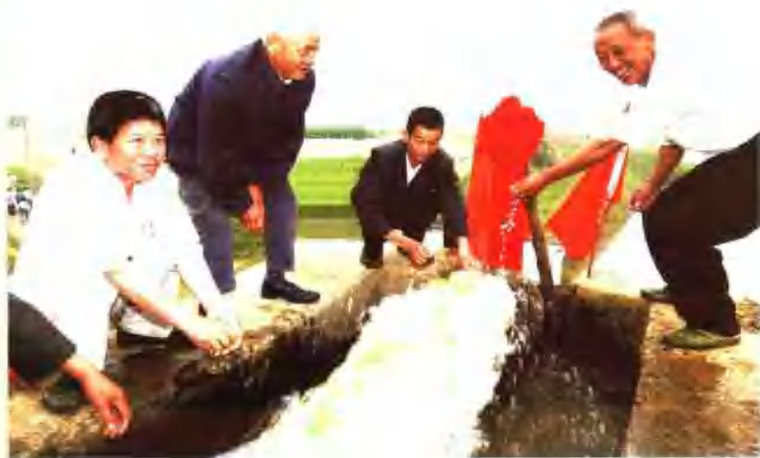
常州市人口计生委帮困扶贫进溧阳老区，为老区人民修建电灌站
