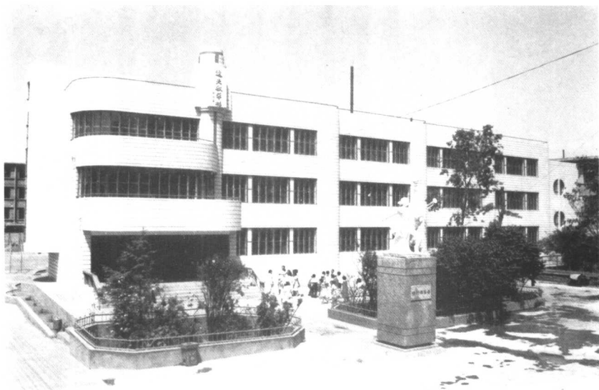
西宁市西关街小学逸夫教学楼外景
