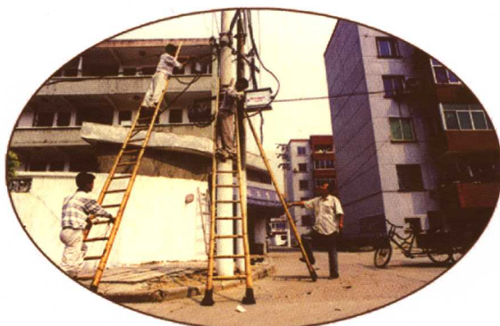
❶ 在居民小区安装有线电视
