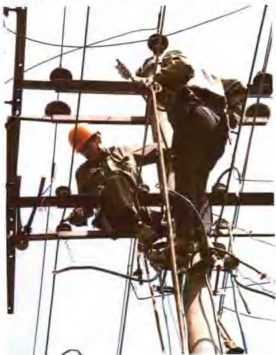
辛勤劳动的电力工人正在检修线路，为企业生产和群众生活服务。
