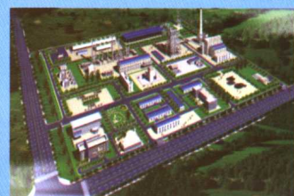
中原大化集团公司煤化工项目50万吨甲醇工程鸟瞰图
