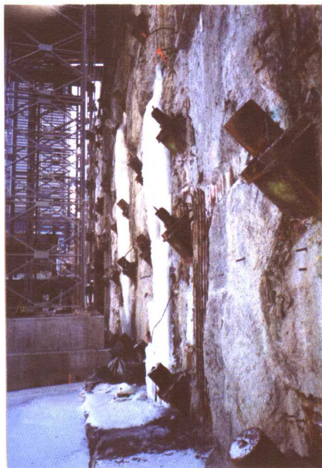
自由街的地下连续壁
