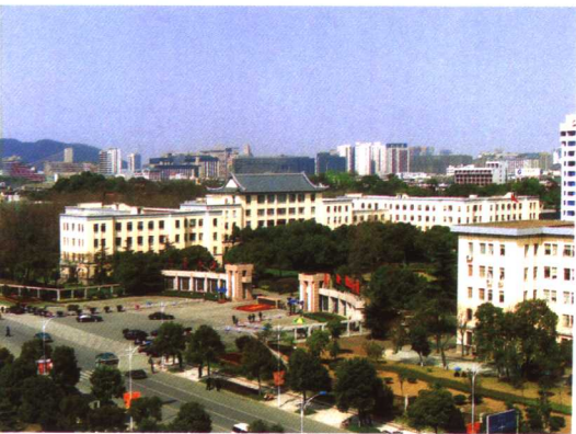
浙江省行政中心一号楼外景
