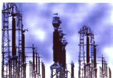
油浸绝缘电流互感器
