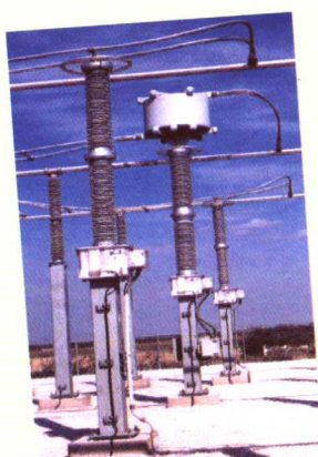
电容式电压互感器
