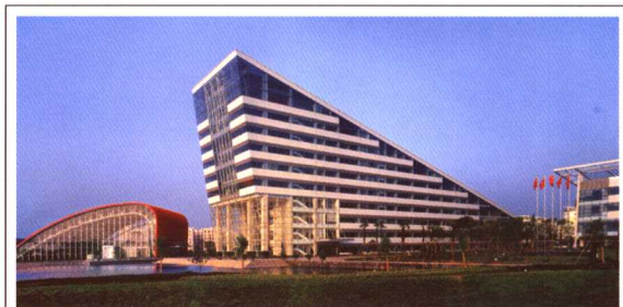
东风汽车公司总部大楼
