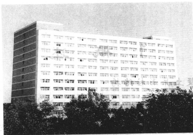
图 1-1 河北工业大学学生宿舍楼（异形柱框架-剪力墙结构）
