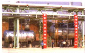
火炬气回收系统水封阀 (ZL 200420079150.8)
