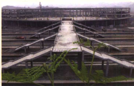
2005年底全线通车的山区致富路—— 渝怀铁路
