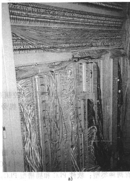
图 1-5 中央扩展 I/O 与远程分布式 I/O 接线对比
