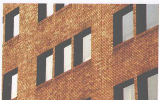
现代建筑平整光洁的清水砖墙。
