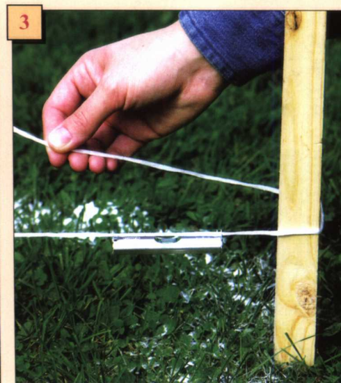
将绳子在成对的木桩上系紧。用直线水平仪调节绳子直至水平。在木桩上测量绳子的高度并计算它们的差值。
