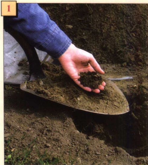
水池衬垫的位置不应低于最高水位线。可以在全年最潮湿的时候，于水池的最低点挖一个试验孔来观测水位情况。
