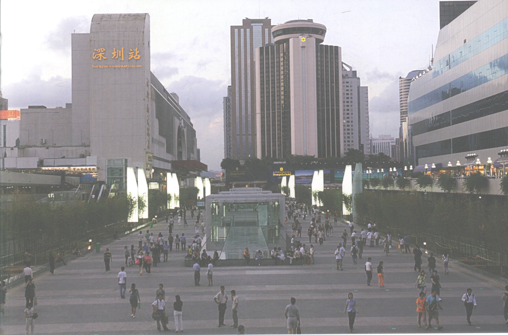
罗湖口岸/火车站地区改造工程竣工实景1
