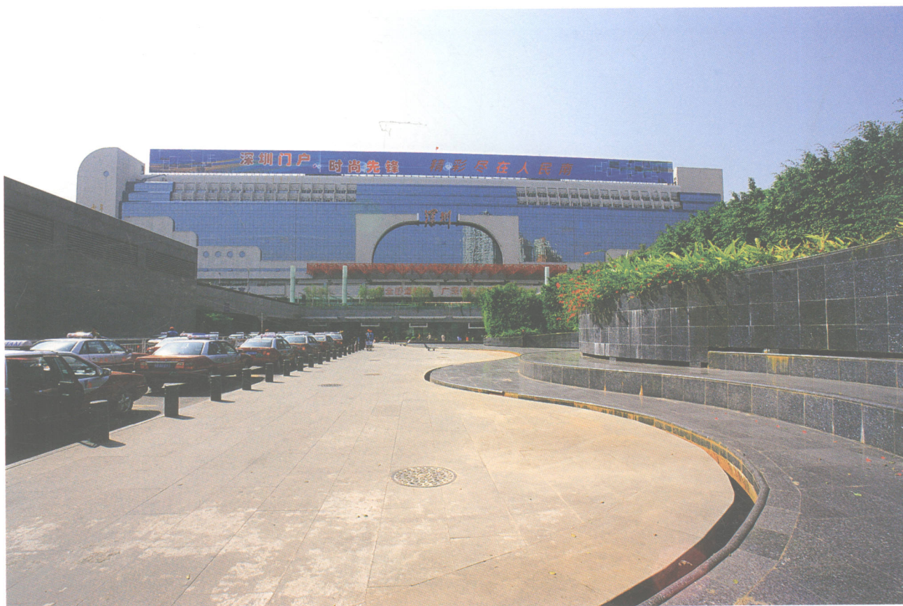
罗湖口岸/火车站地区改造工程竣工实景2
