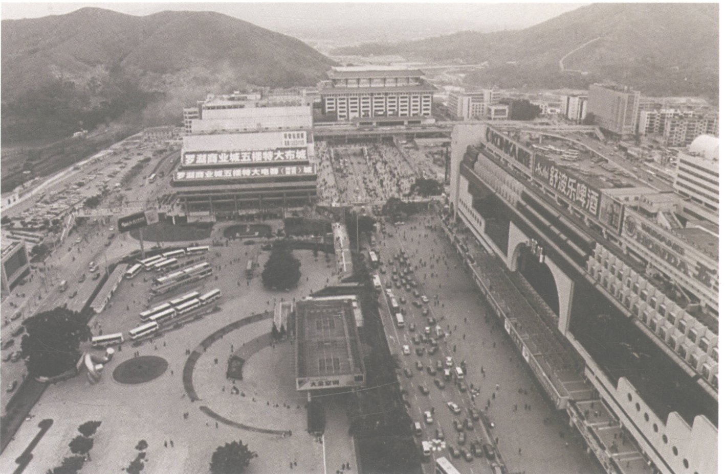
罗湖口岸/火车站地区改造工程施工现场
