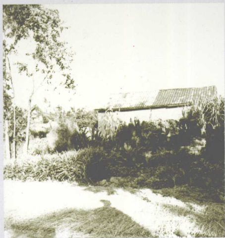
永昌府（保山）板桥杜家庄杜文秀家宅遗址
