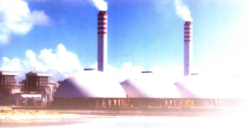
漳州华阳实业有限公司后石电厂
