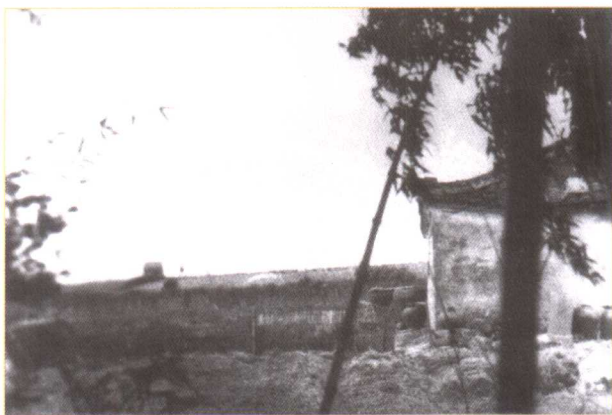
■ 1941年6月18日，浙东人民武装在余姚相公殿毙伤日军 16人。图为战斗遗址。
