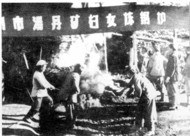
东川市妇女正在进行烘炉劳动。
