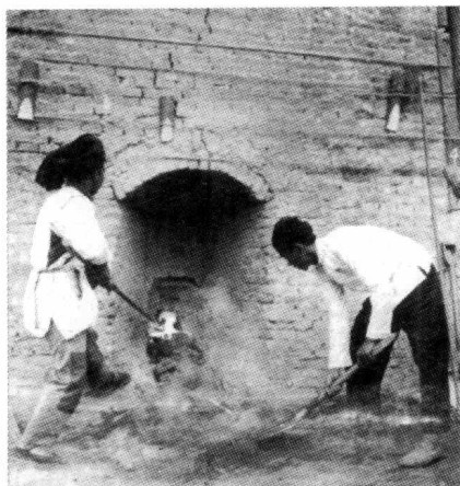
云南民族学院钢铁厂的大高炉正在出铁。
