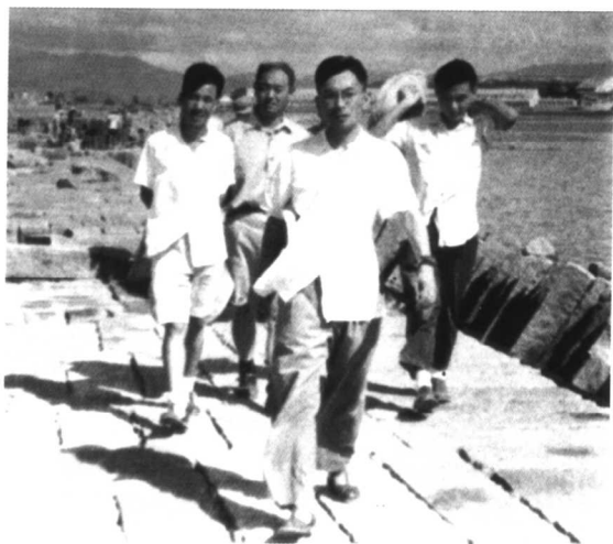
1953年叶 飞(前中)视察 福建厦门海堤 工程
