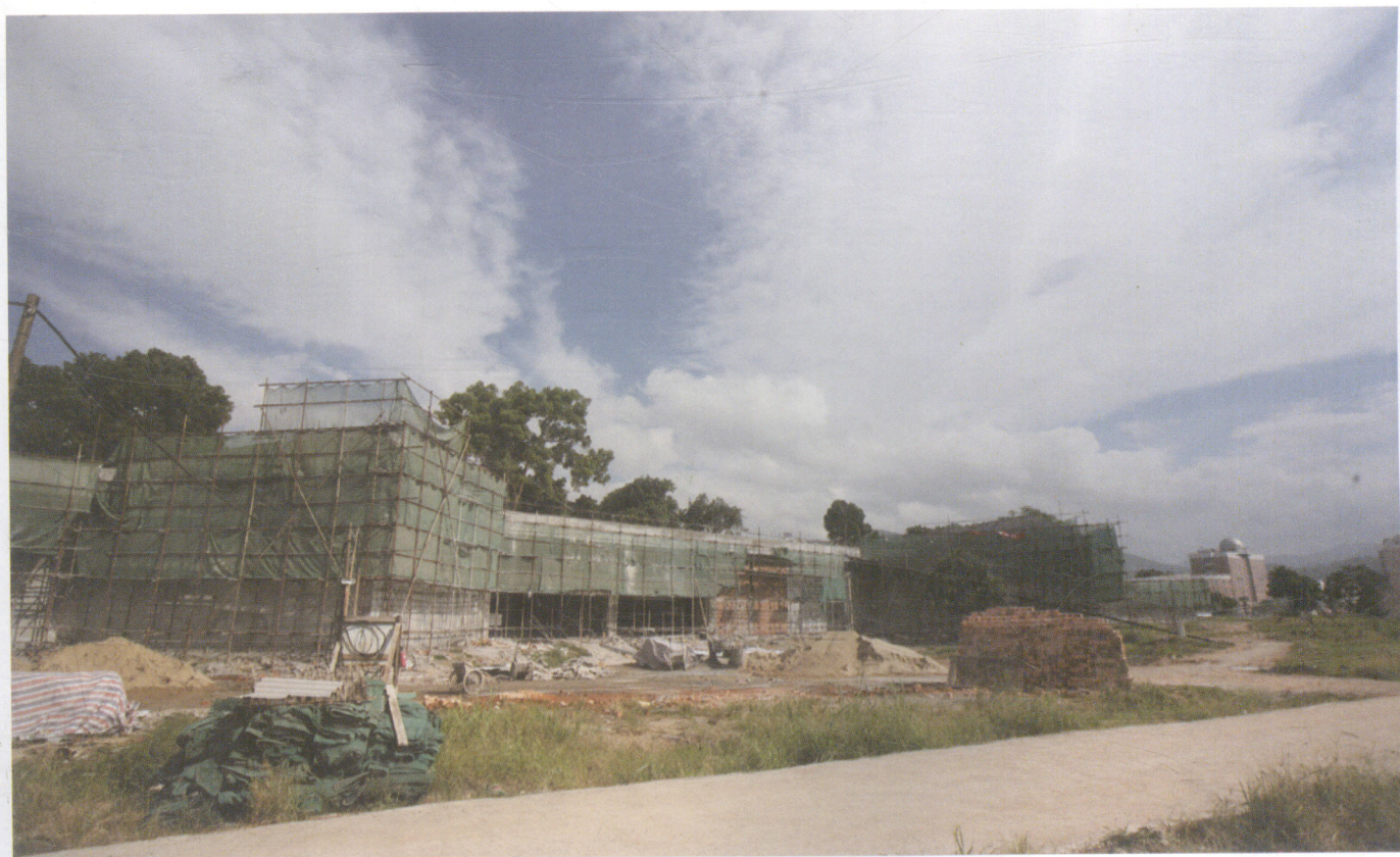
正在建设中的昙石山遗址博物馆新馆
