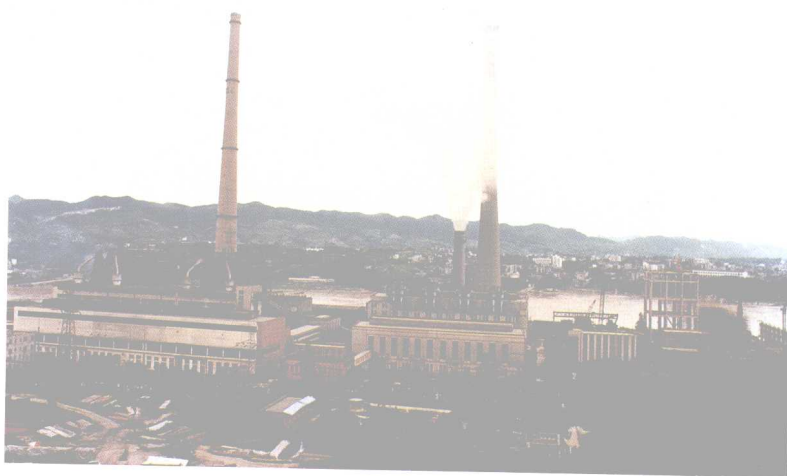
重庆发电厂西厂 技改工程 (邱明源摄 于1989年)
