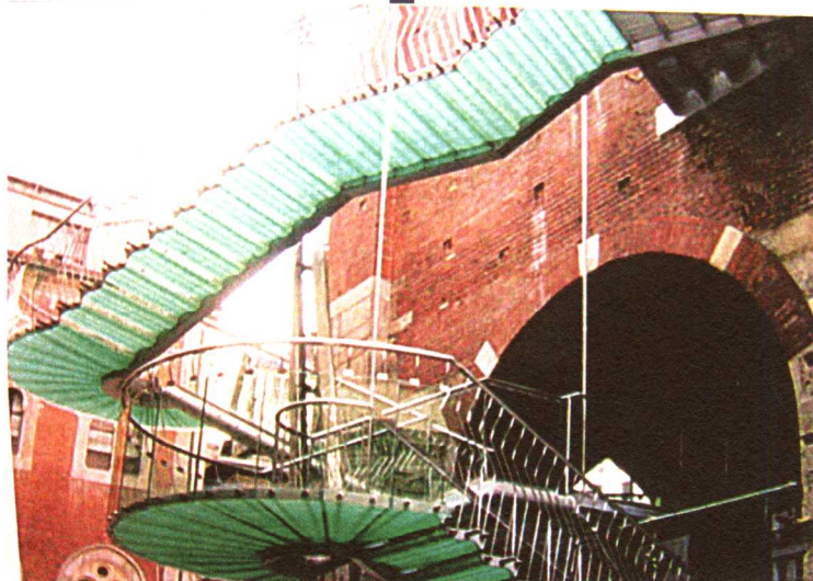
＞米蘭的舊磚造建築，以衝突的手法外搭鋼鐵玻璃樓梯。
