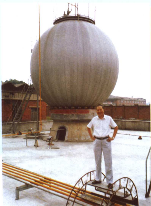
王仲仁在世界上首台用无模胀形法制成的液化气储罐前（容积 200\text{m}^3 ，直径 7.1\text{m} ，厚 24\text{mm} ），1992年
