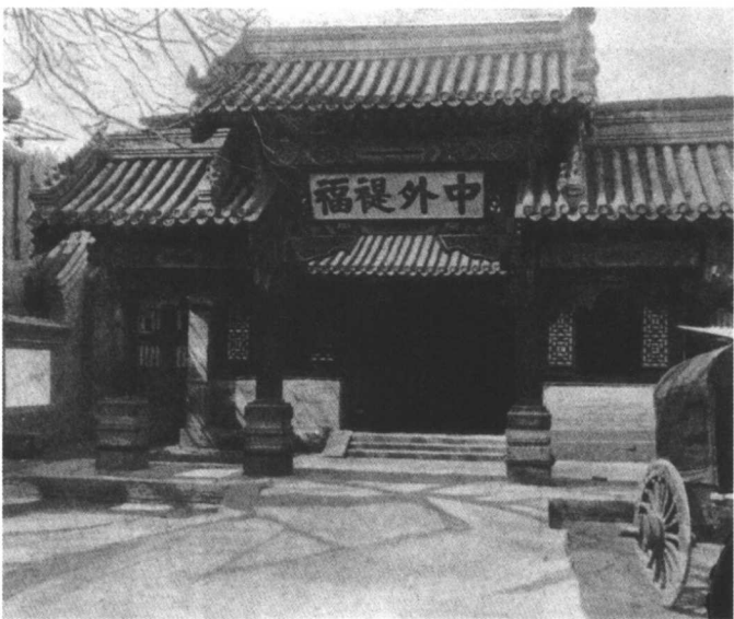
总理衙门大门和内院，全称为“总理通商各国事务衙门”，相当于外交部。
