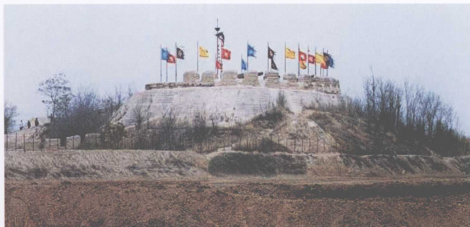
大沽口炮台“威”字炮台主体
