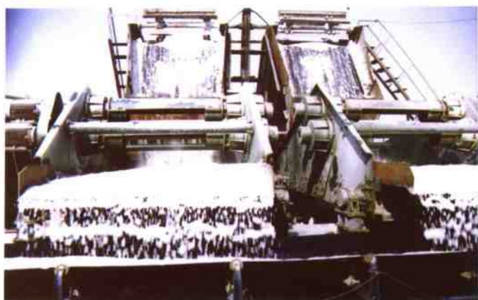
原盐经输盐管道运至脱水机，图为脱水机振动筛进行原盐洗涤工作。
