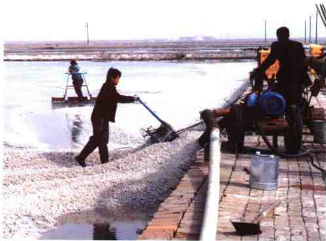
中盐长芦沧州盐业（集团）水力管道收盐机组工作现场
