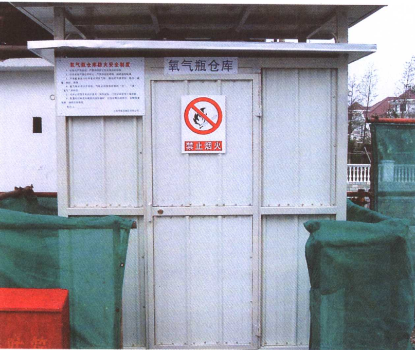
定型化氧气瓶、乙炔瓶仓库 (上海建工集团)
