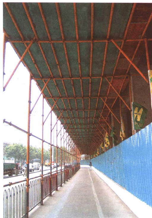
靠马路一侧防护走廊 (四川华西集团)
