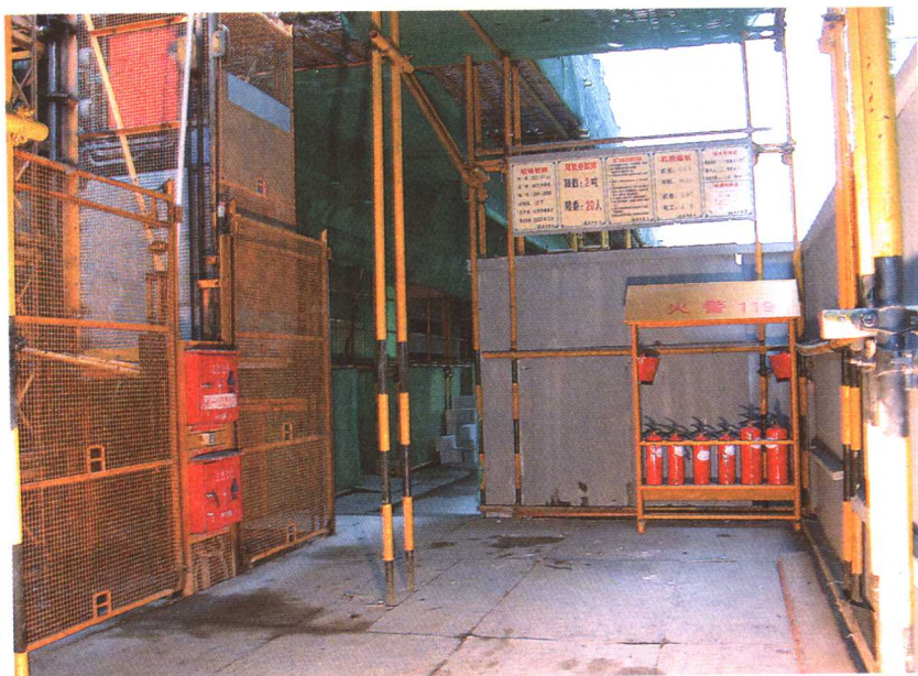
施工人货两用电梯 (苏中建设集团股份有限公司)
