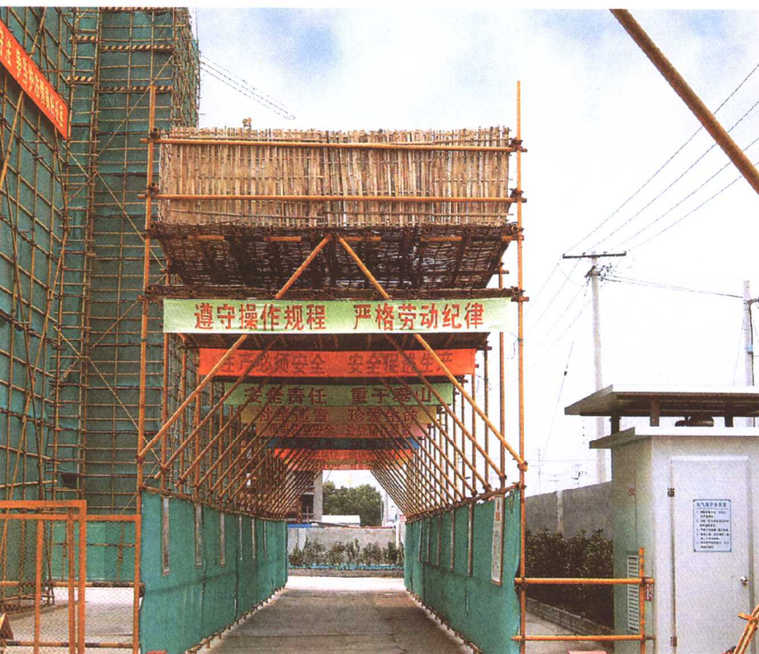
防护通道 (上海建工集团)
