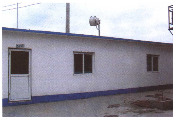
室外监控设备 (中国建筑第四工程局)
