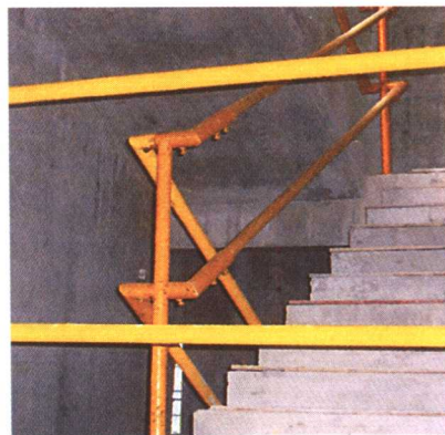
楼梯口 (上海建工集团)
