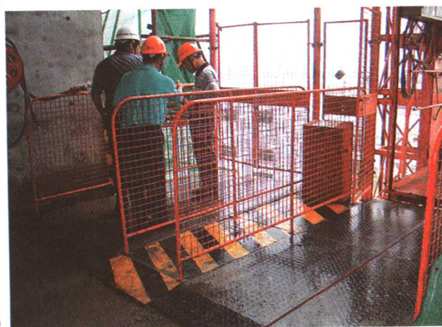
人货两用电梯周边防护 (上海市第四建筑有限公司)
