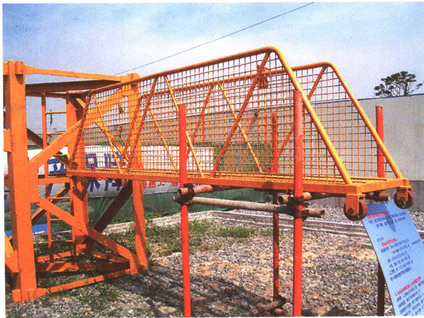
安全设施的定型化、工具化安装 (上海建工集团)
