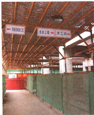
安全通道 (苏中建设集团股份有限公司)
