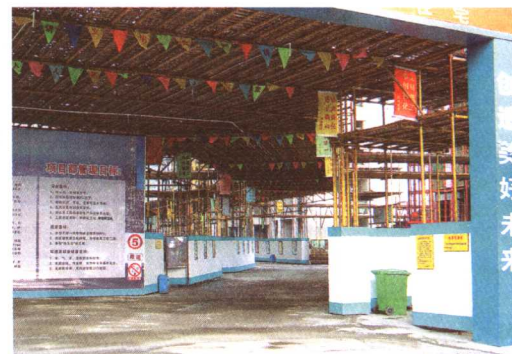
带喷淋装置的防护棚 (苏中建设集团股份有限公司)
