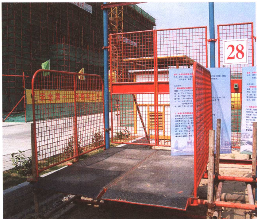
安全设施的定型化、工具化安装 (上海建工集团)
