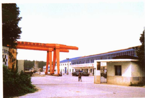
上海华玉混凝土构件厂
