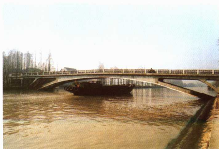
新盛境内之川杨河新华大桥
