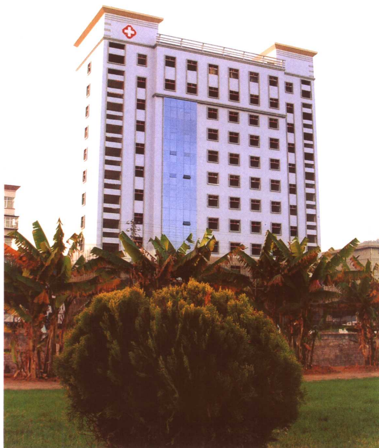
云南省彝医医院综合医技大楼掠影
