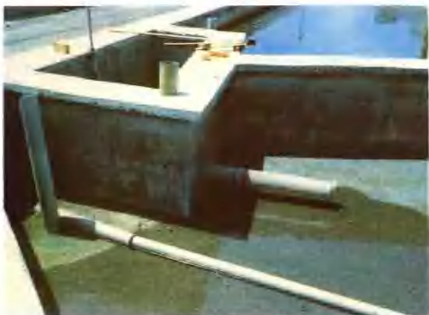
圖22 黑殼蝦苗池的排水口需繫上細網，以避免蝦苗自排水口跑出。
