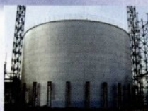
施工中的钢板仓
