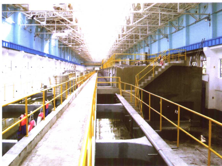
彩图 2 推广厂养虾槽为 6\text{ m} \times 6\text{ m} \times 2.0\text{ m} 的钢筋混凝土池
