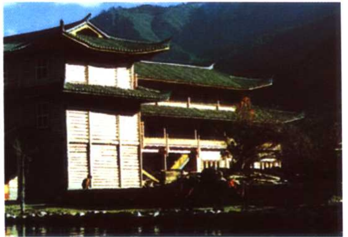
新建的木㼮房 New Wooden House
