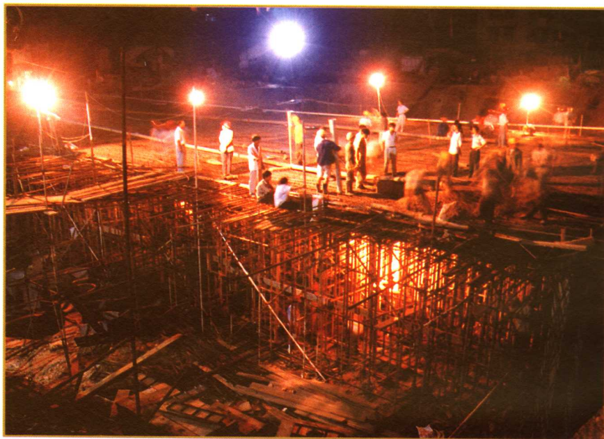
掘开式人防工程夜间施工现场
