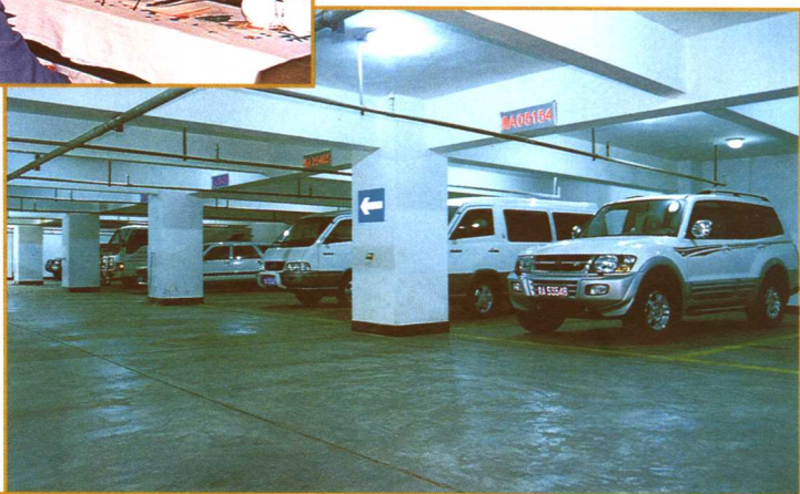
结合地面建筑修建的防空地下室
