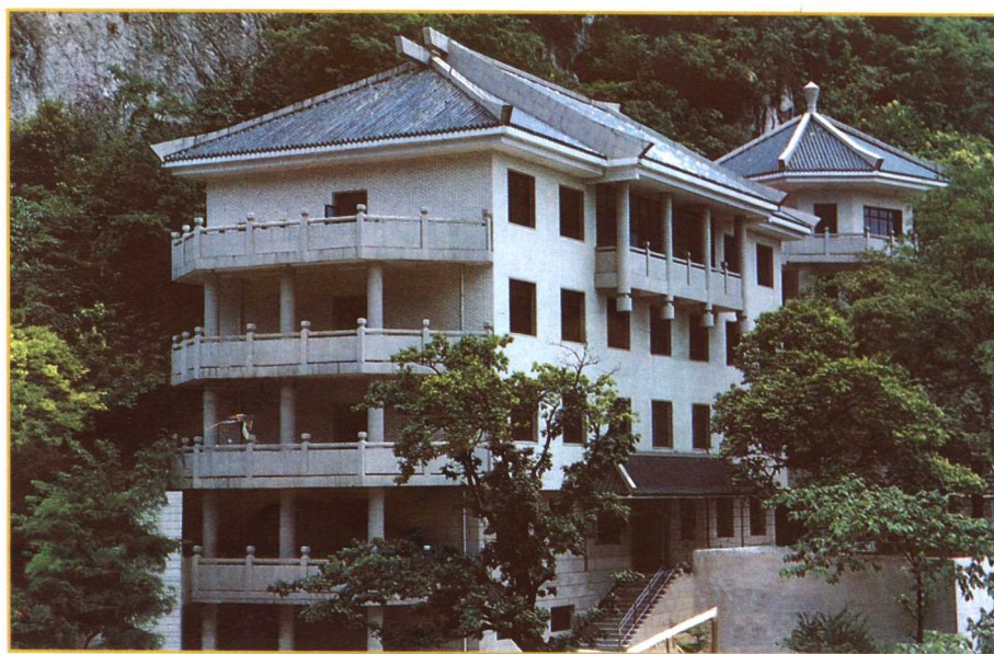
贵阳市人防战备办公室 办公楼外景
