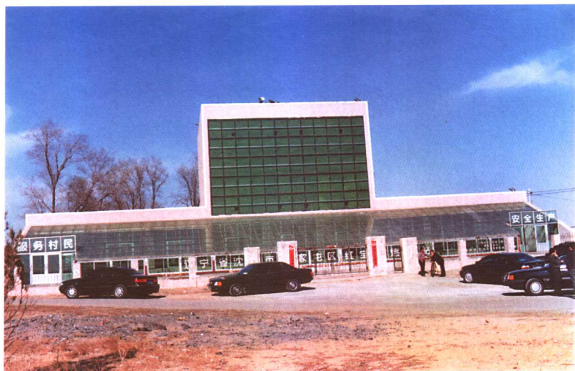
辽宁省沈阳市的生物质气化集中供气工程（秸秆气化）
