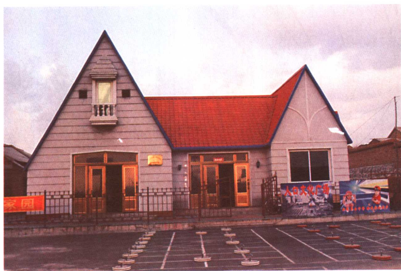
辽宁省鞍山市生物质气化（秸秆气化）集中供气工程
