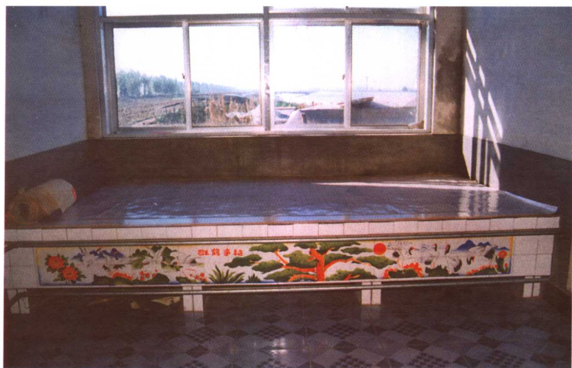
辽宁省本溪市的高效预制组装架空炕连灶（吊炕）
