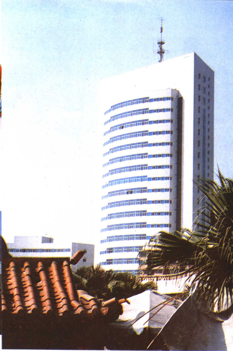
▲成都市电信局长途枢纽大楼
