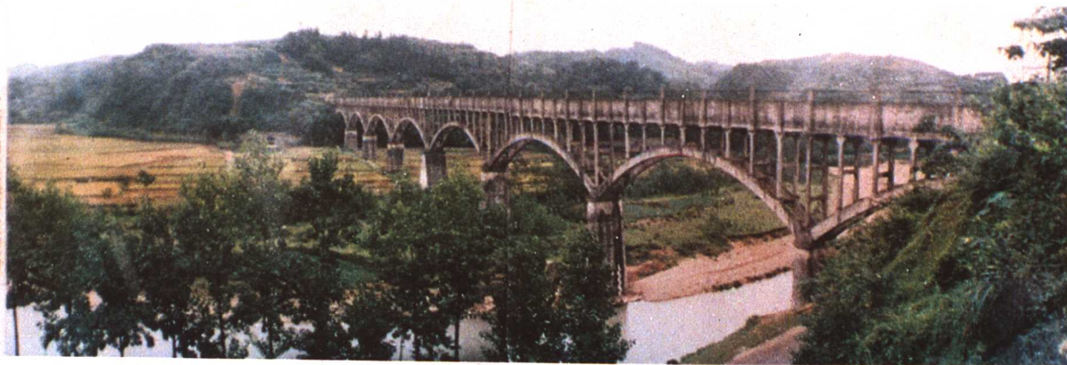
▲引来玉溪河水 灌溉邛蒲台地 (玉溪河引水工程五面山支渠解放渡槽)
