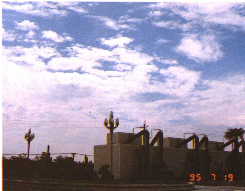
▲西南航空港经济开发区自来水厂
