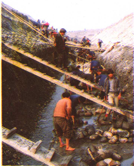
◀热火朝天的水利工地
