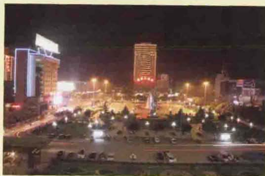
城市亮化工程
