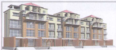
CHA14 大型建筑——居民楼
