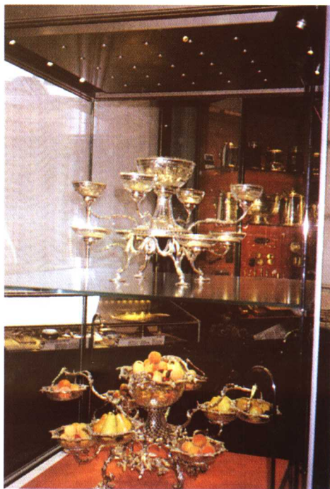
伦敦 Victoria&Albert 博物馆，注意展柜顶上的点光源。也有“牧羊人手杖”从展柜的地板将光传输至展柜中间
