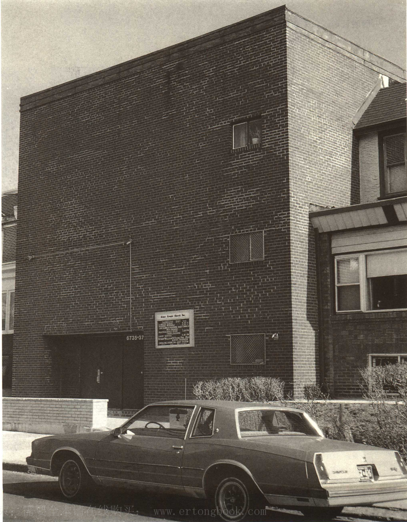
砖墙角部和 楼梯间窗户
