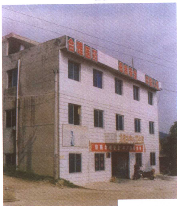
▲ 龙泉中心卫生院 门诊楼（1999年建）
