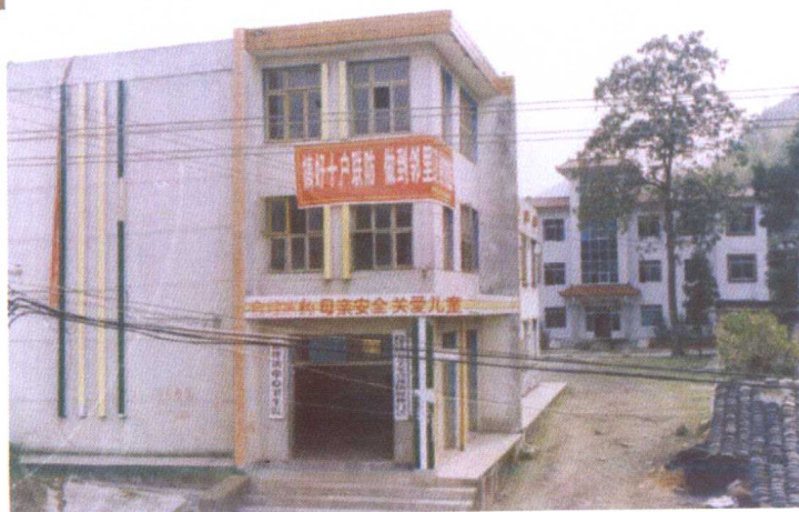
▼ 稳坪中心卫生院，前 为门诊楼（1990年建），后 为住院楼（2002年建）
