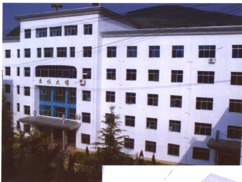
◀ 德江县人民医院 医技大楼(2005建)
