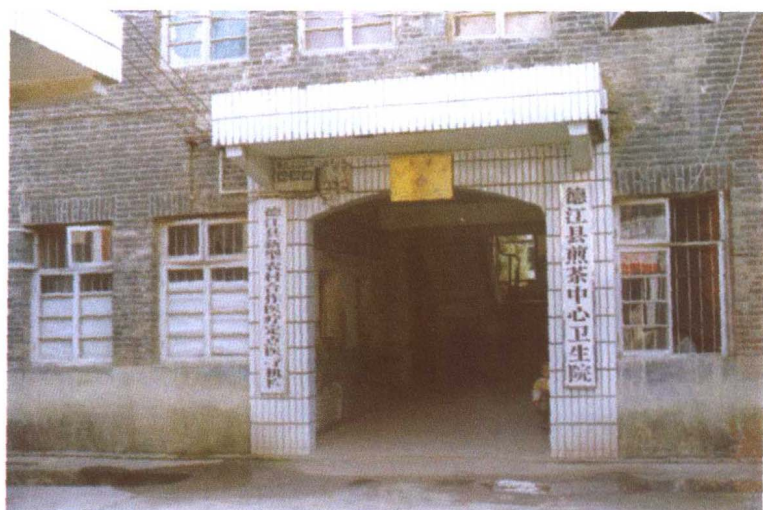
▶ 煎茶中心卫生院 门诊楼 (1974年建)
