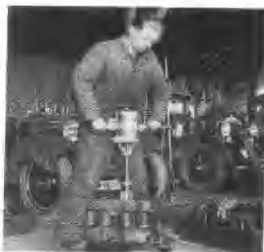
图 1-2 1928 年，工人使用珩磨工具 修磨发动机缸孔
