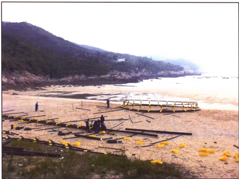
图1 网箱框架安装
