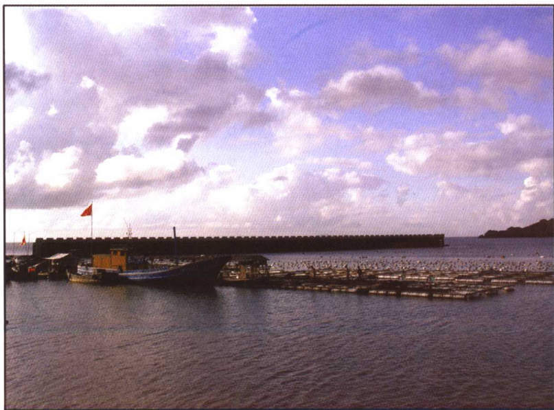
图2 透气式固定防浪堤
